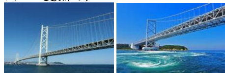
(明石海峡大橋)
