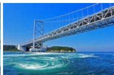
(鳴門海峡大橋)
